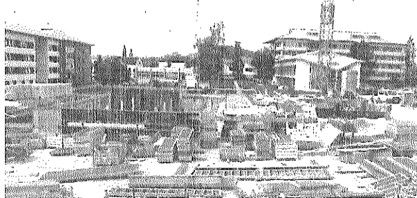
Gebaut wurde schon immer. Letzter größerer Neubau war der der Küche 2009. Im Hintergrund das gelbe Gebäude mit der alten Küche mit Schlachthaus, links das Haus Donautal, rechts die Häuser Baar I und II.
