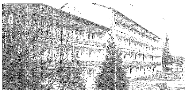
Hier eine ungewöhnliche Ansicht auf das Haus Wartenberg. Es soll durch einen Neubau ersetzt werden. Die Sanierungskosten des vor 60 Jahren errichteten Gebäudes wären zu
